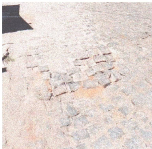
RUA MARIA SALETE – DISTRITO DE SÃO SEBASTIÃO
